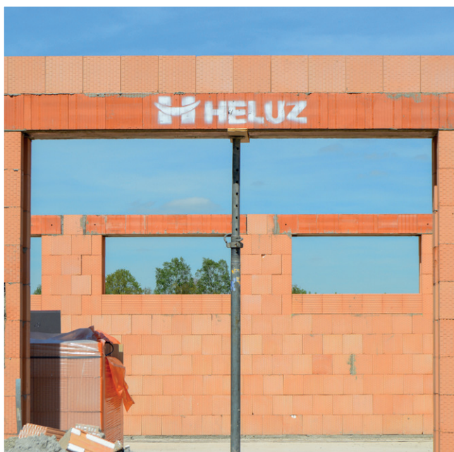
③ Ansicht von außen. Detail der Unterstellung bei größeren Längen.
