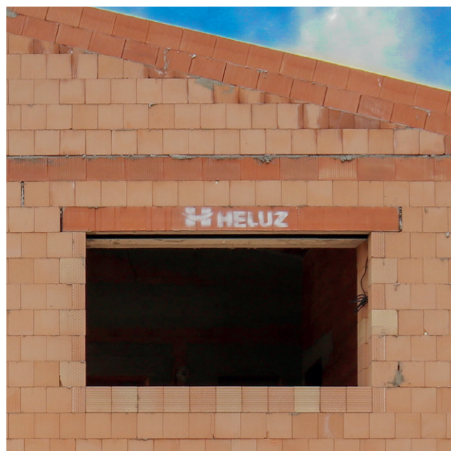
④ Eingebauter tragender Sturz HELUZ FAMILY 3in1.
