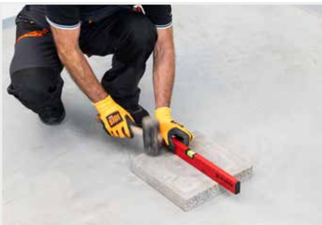
AUSRICHTEN DER FUNDAMENTPLATTE
