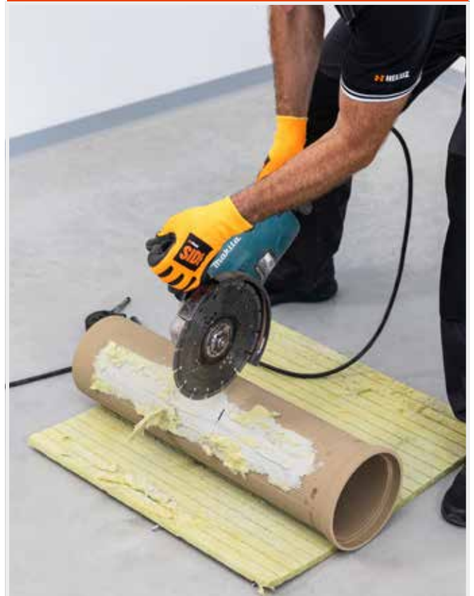
EINSÄTZE MIT EINEM WINKELSCHLEIFER MIT GEEIGNETER SCHEIBE SCHNEIDEN
