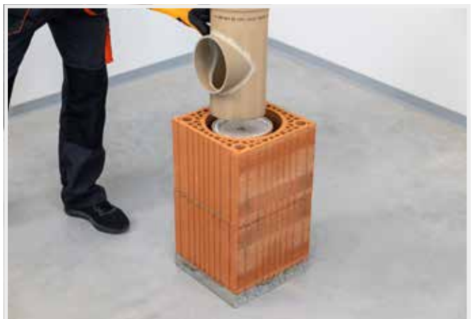
EINSETZEN DER REINIGUNGSÖFFNUNG (ZIEGELBLOCK OHNE WÄRMEDÄMMUNG)
