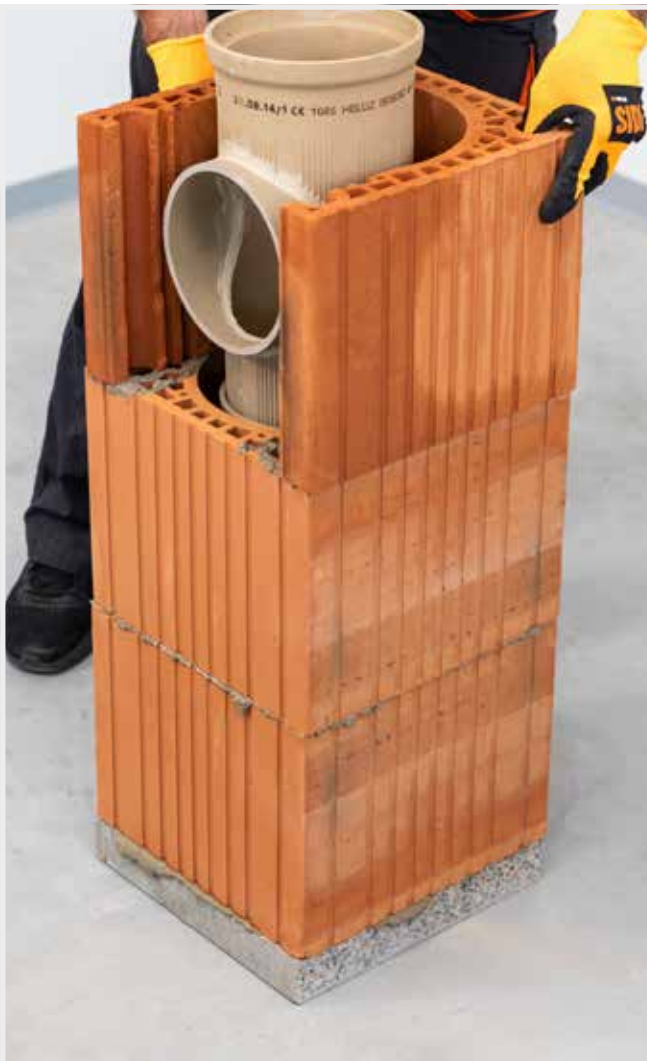
EINSETZEN DER ZUGESCHNITTENEN ZIEGELBLÖCKE
