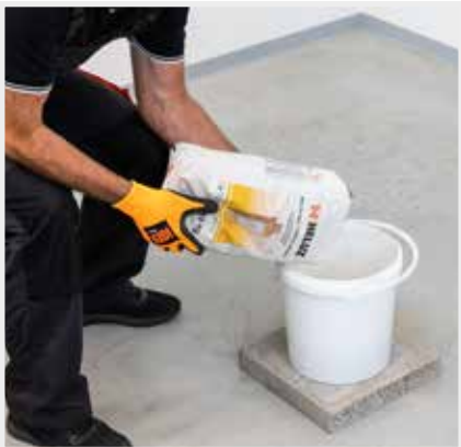
ANMISCHEN DES MAUERMÖRTELS
