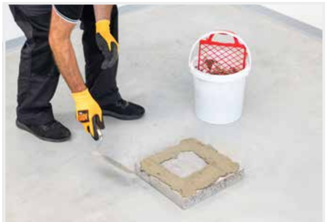
AUFTRAGEN DES MÖRTELS
