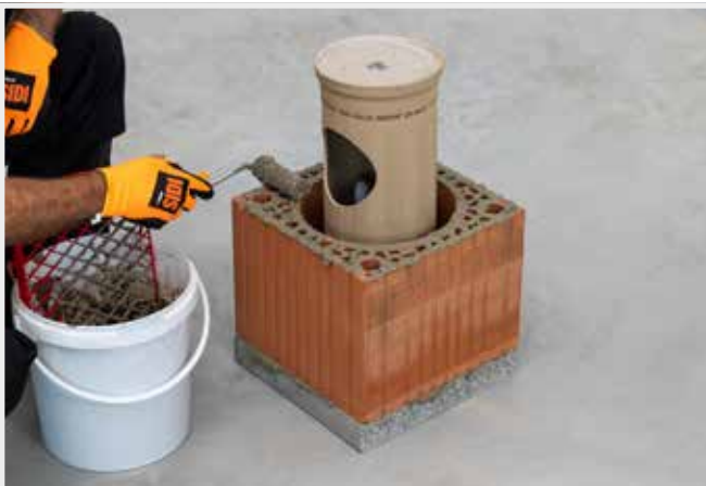
AUFTRAGEN DES MAUERMÖRTELS AUF DIE FUGE
