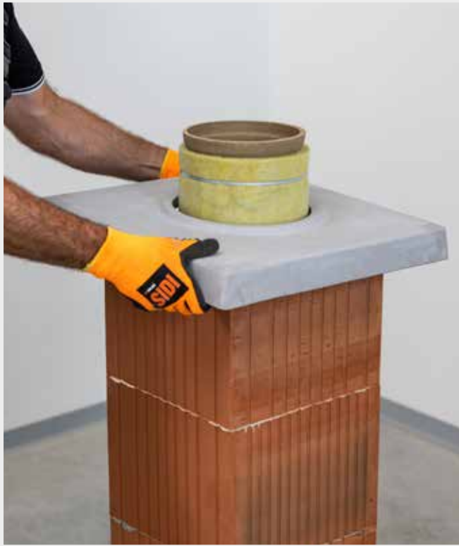
TROCKENMONTAGE DER ABDECKPLATTE, UM DAS DETAIL DES ABSCHLUSSES ZU MESSEN
