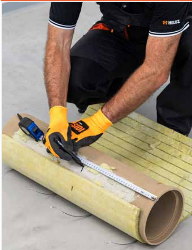
MÖGLICHES SCHNEIDEN DES EINSATZ, UM DIE GEWÜNSCHTE HÖHE DES RAUCHABZUGS ZU ERREICHEN
