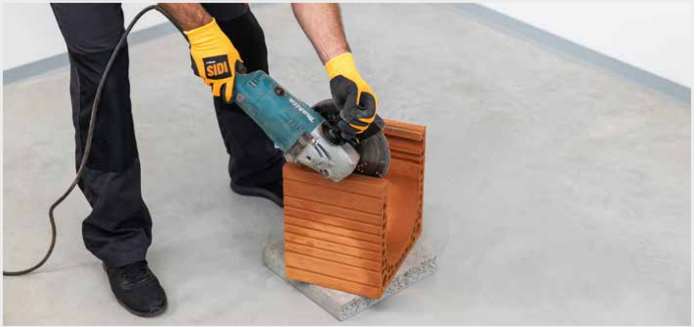
ZUSCHNEIDEN DER ZIEGELBLÖCKE NACH BEDARF
