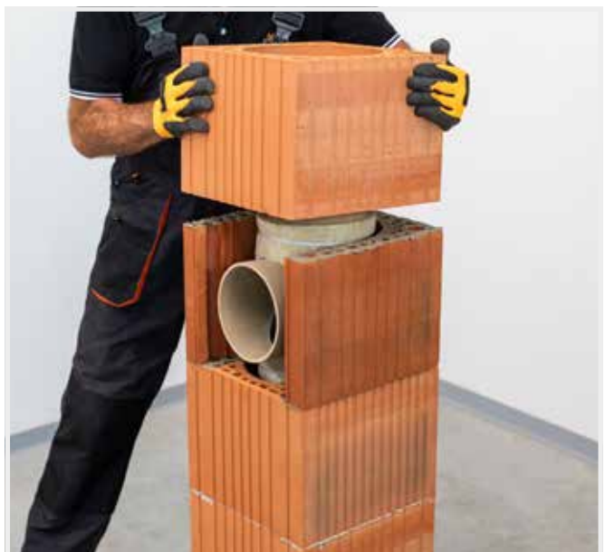
FORTSETZUNG DER MAURERARBEITEN
