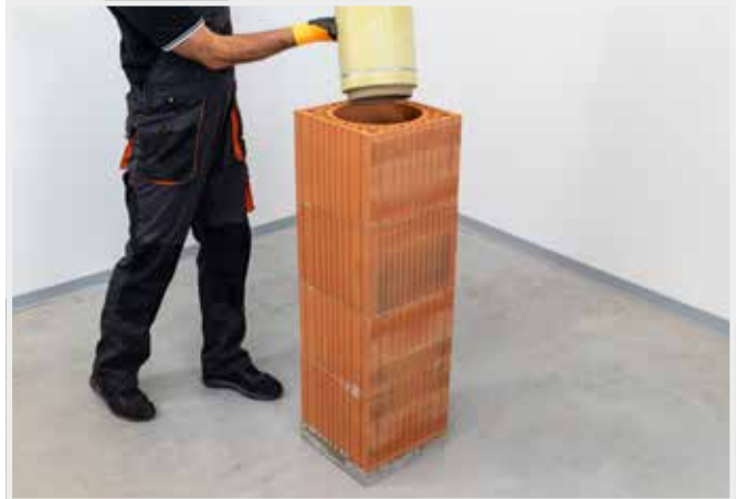
EINSETZEN DES WERKSEITIG ISOLIERTEN EINSATZES
