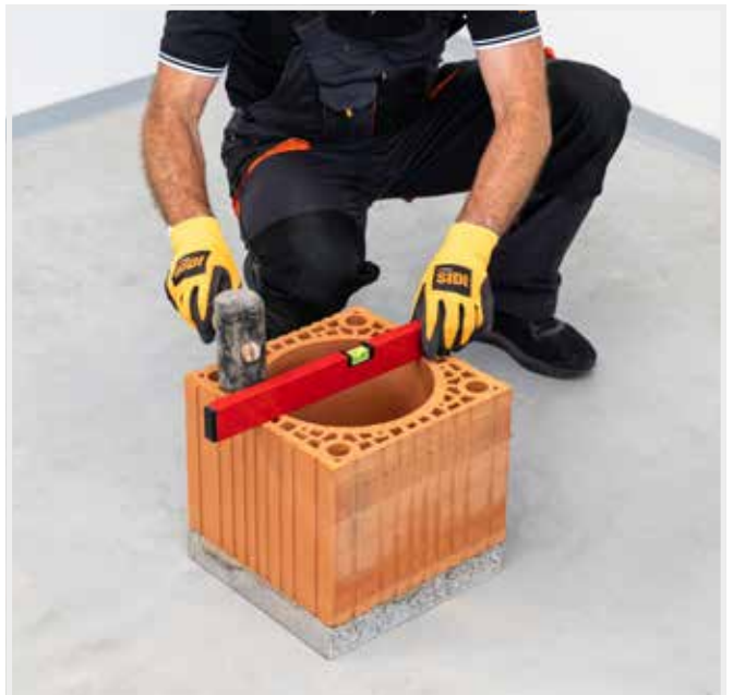
EINSETZEN DES ERSTEN SCHORNSTEINBLOCKS UND SEIN GENAUES AUSRICHTEN
