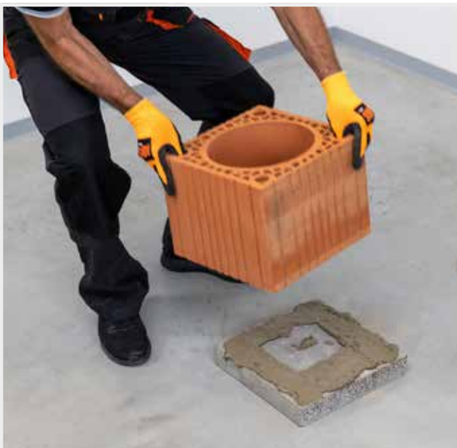
EINSETZEN DES ERSTEN SCHORNSTEINBLOCKS UND SEIN GENAUES AUSRICHTEN
