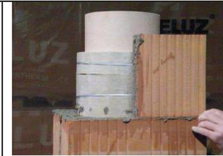
7. Ist der Überdachteil des Kamins höher als 1,3 m oder aus den Ringen GRAND (HCP, HCB) aufgebaut, muss eine Verfestigungsbewehrung (HZV) verwendet werden, deren Länge dem Zweifachen der Höhe des Überdachteils entspricht. Aus dem Grund ist es wichtig, die Höhe zu berechnen, in der wir in die Ziegelformsteine Blindbleche einlegen und mit der Montage der Bewehrung beginnen. Detaillierte Folge finden Sie in der Montageanleitung für den Überdachteil.
