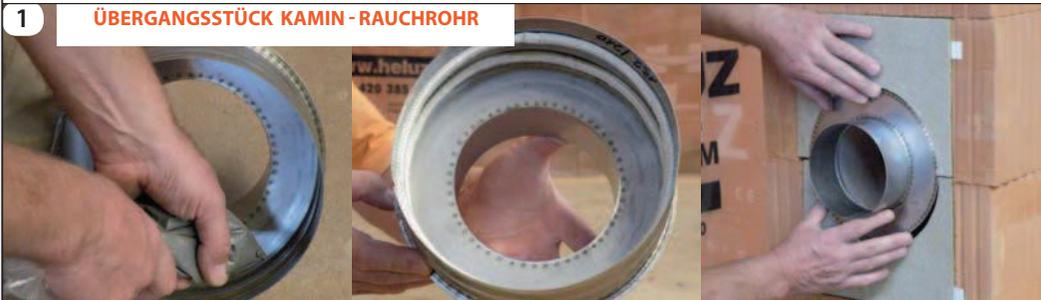
In die **Nuten des Übergangsstücks Kamin/Rauchrohr (HRK) tragen** wir mit Hilfe des mitgelieferten Beutels (HPH) entsprechend der Anweisung auf der Verpackung vorbereitete **Fugenvergussmasse (HHS)** ein. Die mitgelieferte Dichtungsschnur wird in die Nuten mit der Fugenmasse gelegt und einen Tag aushärten. Die Stirnisolierplatte (HIB) wird angepasst und **das Übergangsstück wird von außen auf die Fuchsmündung aufgeschoben.** Nachfolgend kann der Rauchabzug angeschlossen werden.
