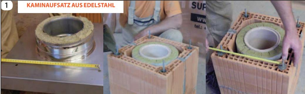
Die keramischen Formsteine werden in erforderliche Höhe ausgemauert und die **Bewehrung** (zusammengestellt laut Anweisung oben) **wird so abgeschnitten, damit sie über den austragenden Teil des Kaminaufsatzes (HXV) herausragt**. Wir vermessen die Entfernung der Öffnungen in austragendem Teil, vergießen die Gewindestangen mit der Vergussmasse (HCZ) und anpassen die Bewehrung auf gleichen Lochabstand.
