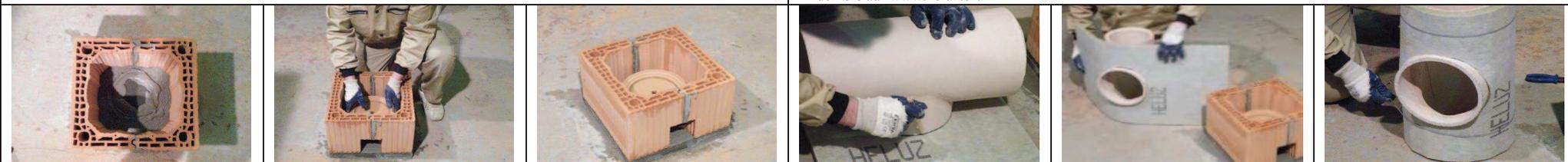
3. In die Mitte der Formsteine tragen wir den Klebemörtel auf, in den der Kondensatbehälter (HVJ). In den Behälter stellen wir durch die Seitenöffnung den Kondensatbecher (HSK) auf. Die Oberfläche des Kondensatbehälters (HVJ) muss während der Montage zugedeckt sein, damit die Öffnung des Kondensatablaufs nicht verschmutzt (verschlammt) wird. Der Anschluss für die Kamintür wird nicht zugedeckt.
