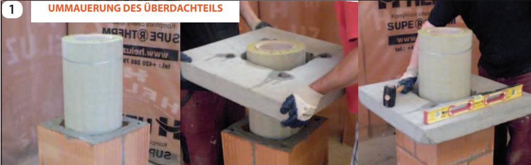
Der Kaminkörper wird bis in den Dachboden ausgebaut. Die keramischen Kaminformsteine werden befeuchtet und mit **mindestens 0,5 cm hoher Schicht Klebemörtels (HLM) bestrichen**. Die Kragplatte (HDK) wird befeuchtet, versetzt und mittels Gummihammer und Wasserwaage ausgeglichen.
