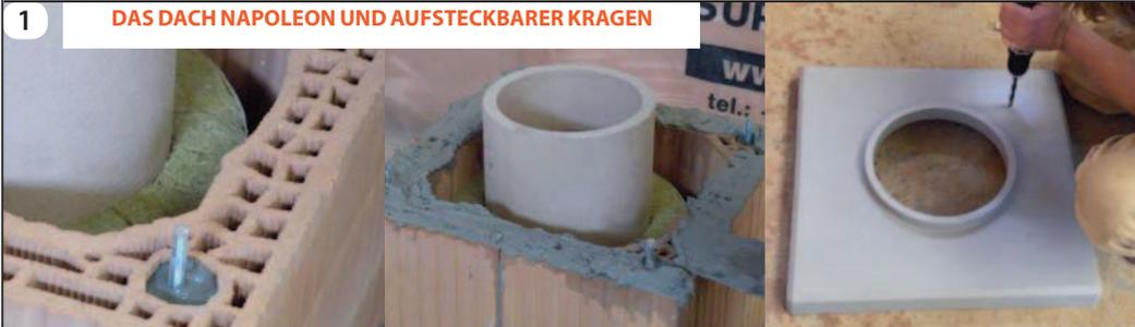
Die keramischen Formsteine werden in erforderliche Höhe ausgemauert und die **Bewehrung** (zusammengestellt laut Anweisung oben) **wird so abgeschnitten, damit sie über die Abdeckplatte zur Befestigung des Dachs Napoleon (HUN, HUNM) herausragt.** Die Gewindestangen werden zentriert und mit Vergussmasse vergossen. Letzte Formsteinreihe wird befeuchtet und mit **mindestens 0,5 cm hoher Schicht des Klebemörtels** behandelt, in die dann die Abdeckplatte versetzt wird.
